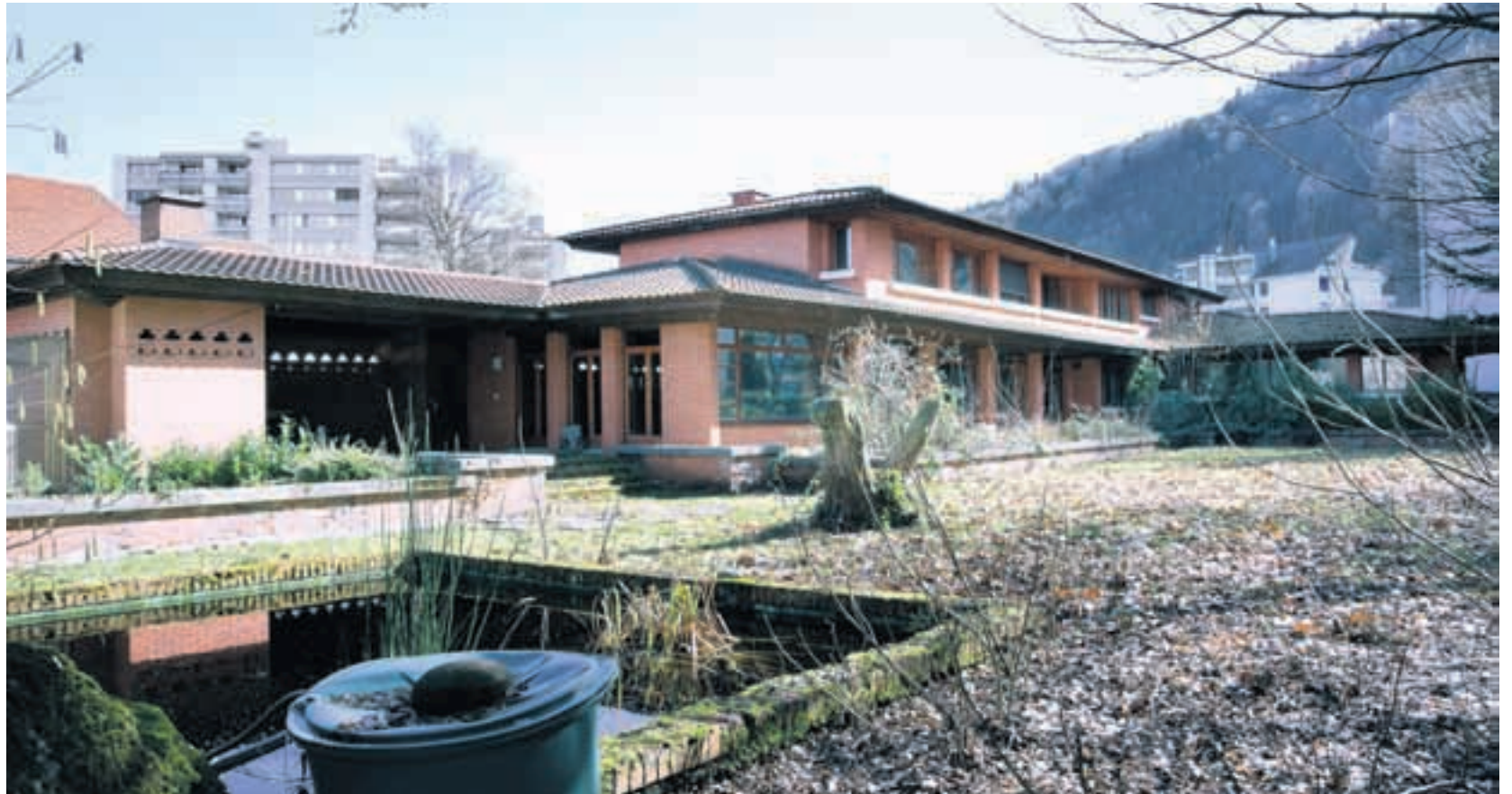
In diesem Einfamilienhaus mit angegliederter Arztpraxis werden zwölf Patientenzimmer eingerichtet.
